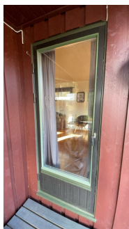
Malt balkongdør i tre med 3-lags glass.
