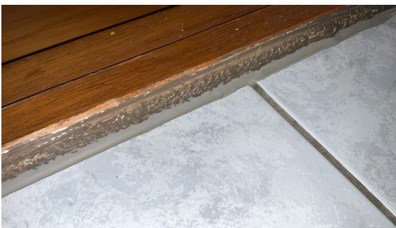
Membran er limt mot dørterskel.
