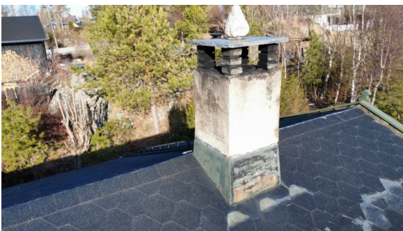
Pipe har tilkomst via takstige
