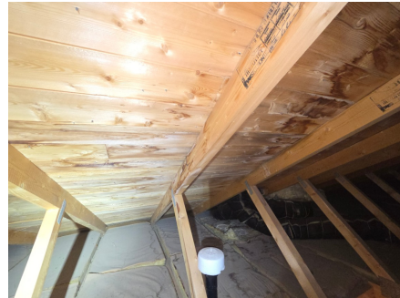
Fuktskjolder i undertak, ingen fukt på befaringsdagen
