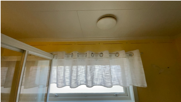
Avtrekkventil i himling
