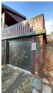
Garasje i underetasjen med veranda i 1. etasje
