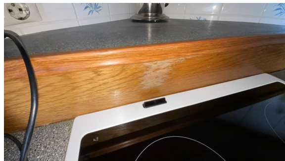
Lite merke bak komfyr grunnet varm damp fra stekeovn.
