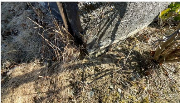
Synlig grunnmursplast på sidene
