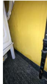
Vegg på vaskerom, ingen synlige saltutslag eller fuktinntregning.
