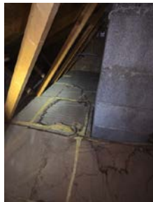
Fuktskjolder på isolasjon ved pipe, ingen fukt ved befaringen
