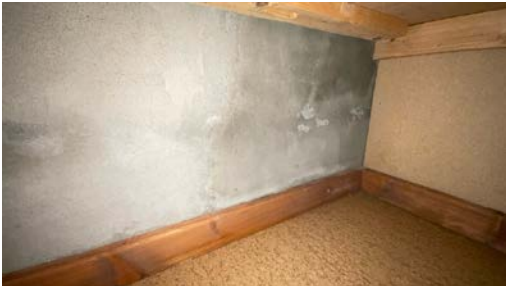
Vegg i bod mot stue, ingen synlige saltutslag eller fuktinntregning.
