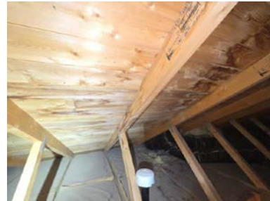
Fuktskjolder i undertak, ingen fukt på befaringsdagen
