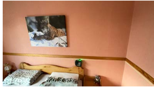
1. etasje Plassering av laser ved kontroll av soverom. Det er målt 15 mm høydeforskjell gjennom rommet. TG 2.
