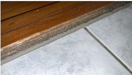
Membran er limt mot dørterskel.
