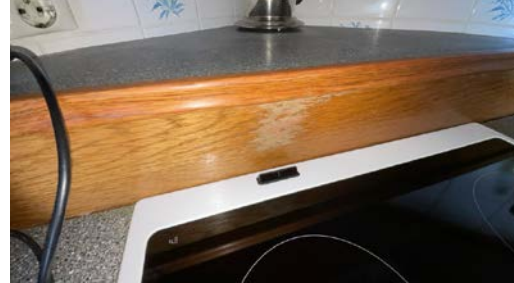
Lite merke bak komfyр grunnet varm damp fra stekeovn.
