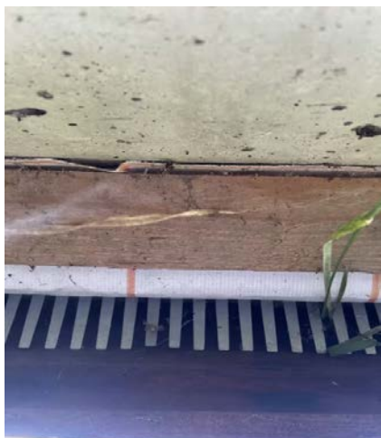
Viser lufting og etablert musebånd.
