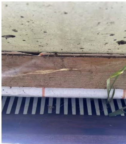
Viser lufting og etablert musebånd.
