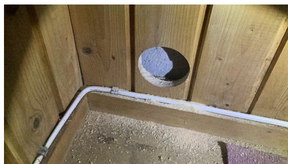
Det er foretatt hulltaking, men fuktmåling kunne ikke utføres.
