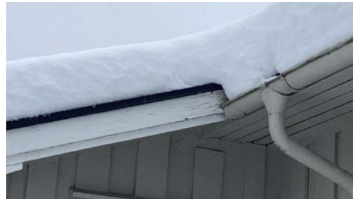
Eksempel på slitasje.
