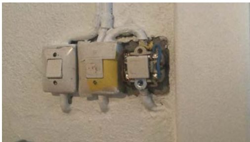
Løst deksel på bryter.
