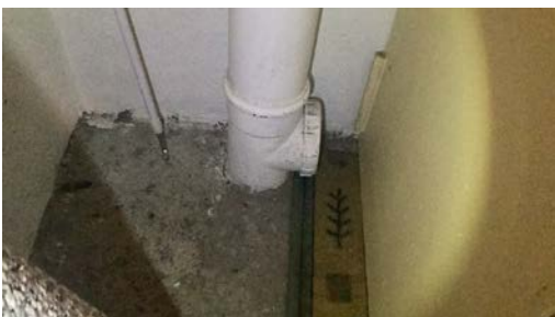
Stakepunkt i kjeller.
