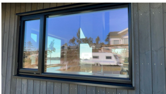
Eksempel på vindu i yttervegg.
