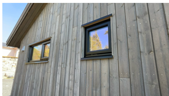
Eksempel på vindu i yttervegg.
