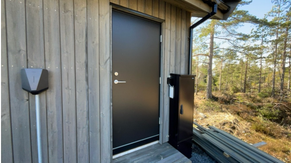
Dør inn til bod.
