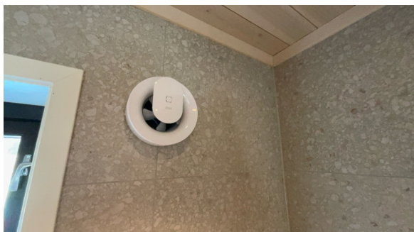
Montert avtrekk i vegg.
