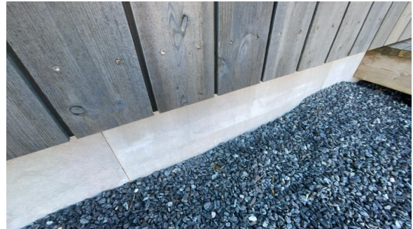
Del av grunnmur.
