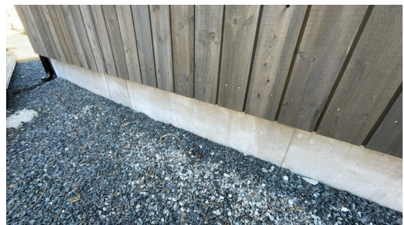
Del av grunnmur.
