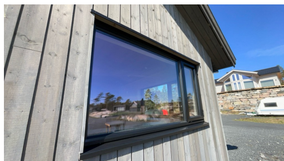
Eksempel på vindu i yttervegg.
