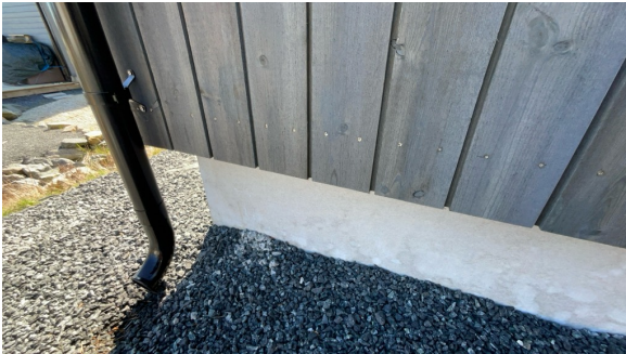
Del av grunnmur.
