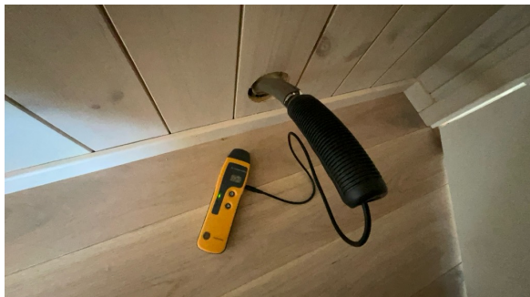
Hull for kontroll av fukt.
