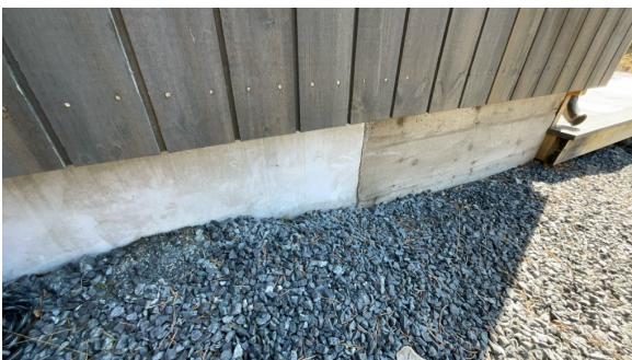
Del av grunnmur.
