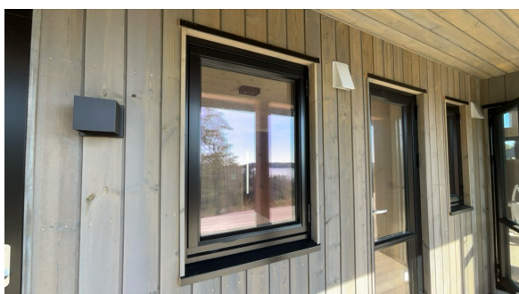
Eksempel på vindu i yttervegg.
