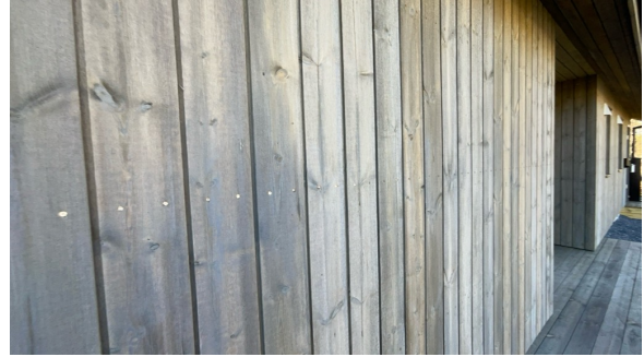
Del av vegg.
