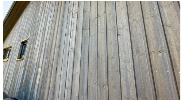
Del av vegg.
