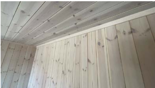
Del av vegg - tak.
