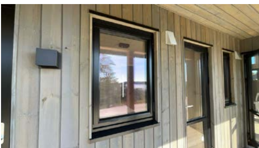
Eksempel på vindu i yttervegg.
