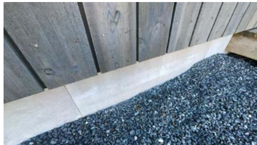
Del av grunnmur.
