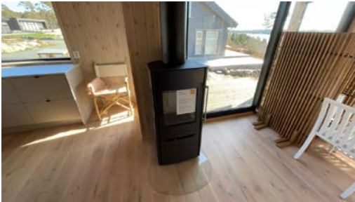
Montert ovn i stue.
