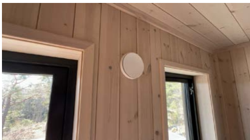
Eksempel på montert ventil i vegg.
