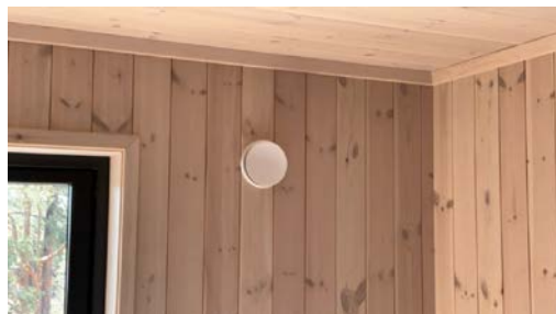
Eksempel på montert ventil i vegg.
