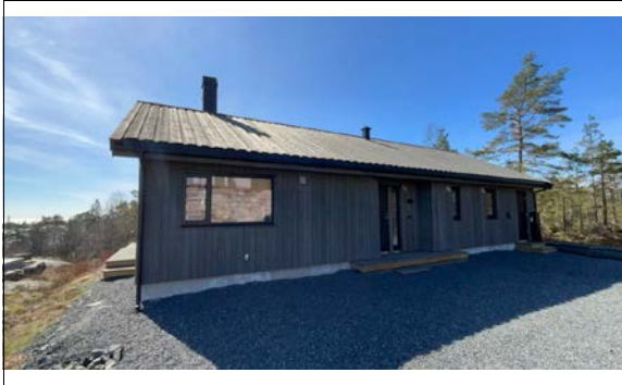
Hytte oppført på eiendommen.
