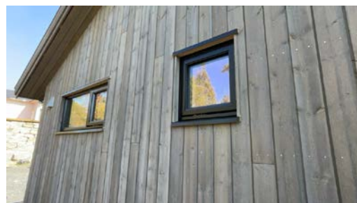
Eksempel på vindu i yttervegg.
