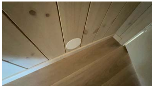
Lokk over hull.
