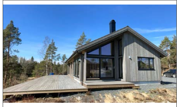
Hytte oppført på eiendommen.
