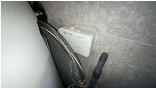
Del av rør til vann.
