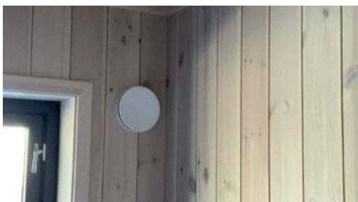
Eksempel på montert ventil i vegg.
