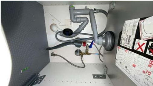
Del av rør til vann.
