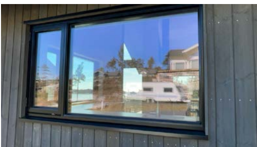
Eksempel på vindu i yttervegg.
