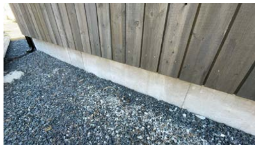
Del av grunnmur.
