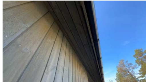
Del av gesims.
