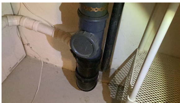
Stakepunkt i kjeller.
