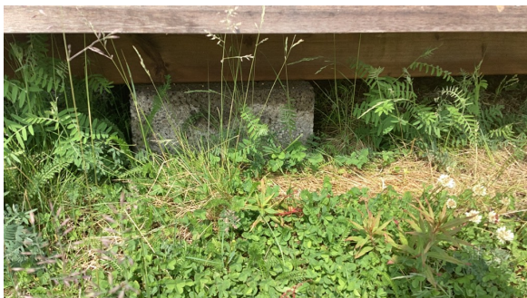
Eksempel på fundamentering.
