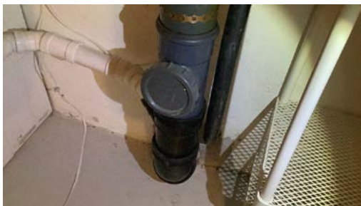
Stakepunkt i kjeller.
