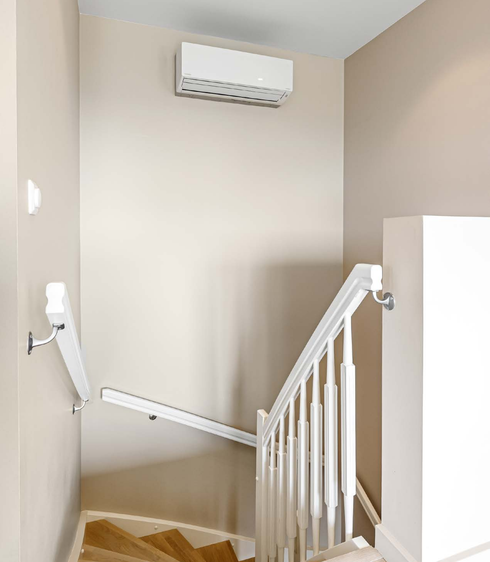
Trapp mellom etasjene, samt montert luft til luft varmepumpe på vegg.
