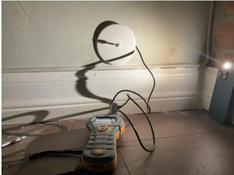
Fuktmåling bak dusjen.
