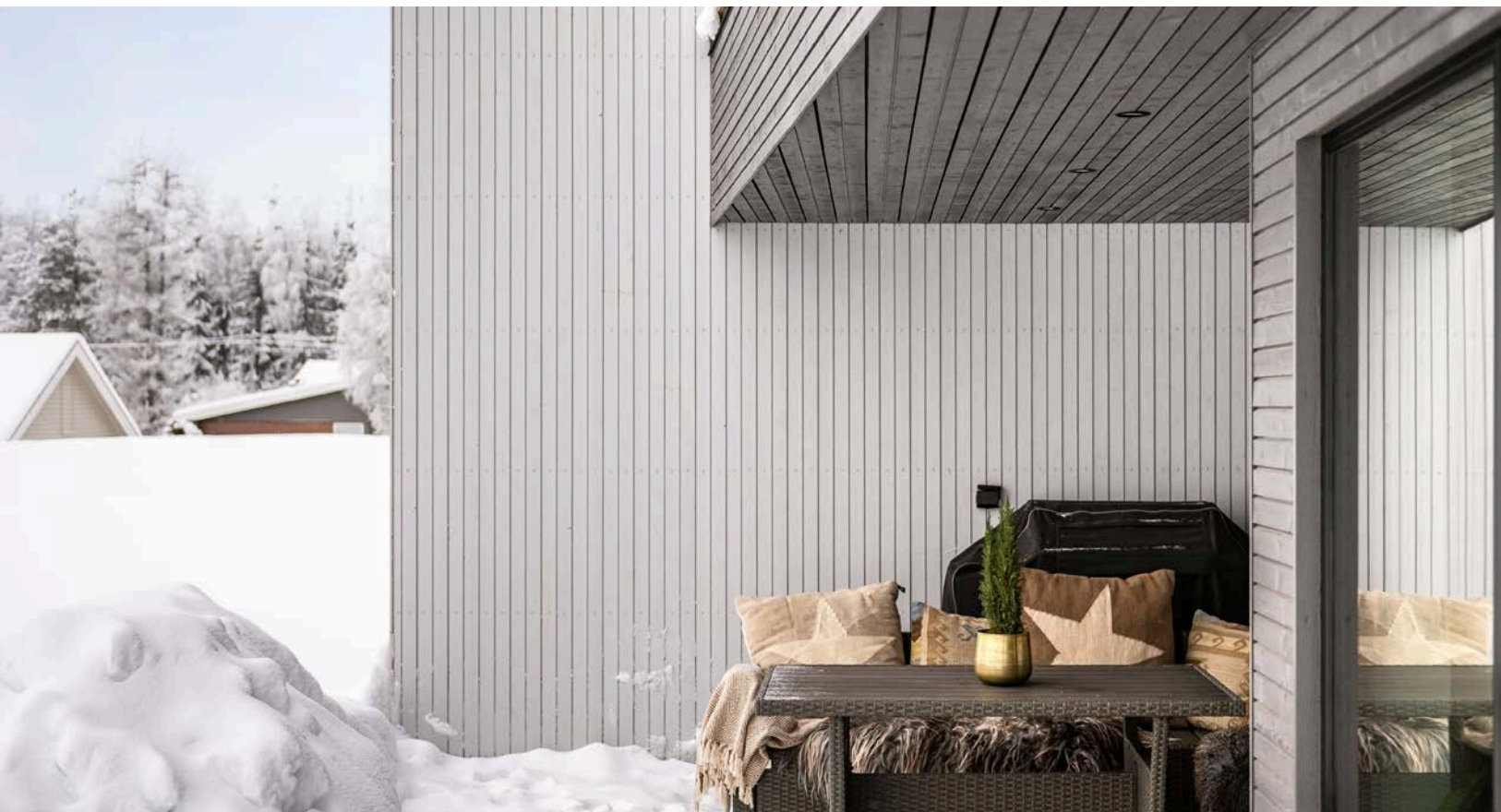
Terrassen er delvis overbygget med innfelte downlights i himlingen, har impregnerte terrassebord på gulv og god plass til sittegruppe etter eget ønske og behov. Det er også montert utebelysning og stikkontakt.
