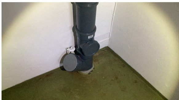
Stakepunkt i kjeller.
