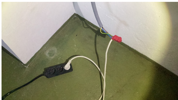
Eksempel på ulovlig kobling.
