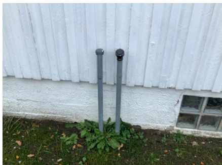
Nedgravet oljetank på eiendommen.
