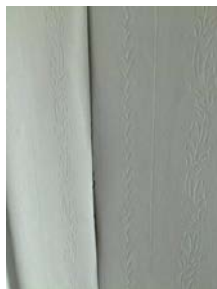
Eksempel på tapet som løsner i skjøt.
