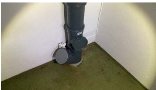
Stakepunkt i kjeller.
