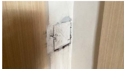
Sotluke i kjeller.
