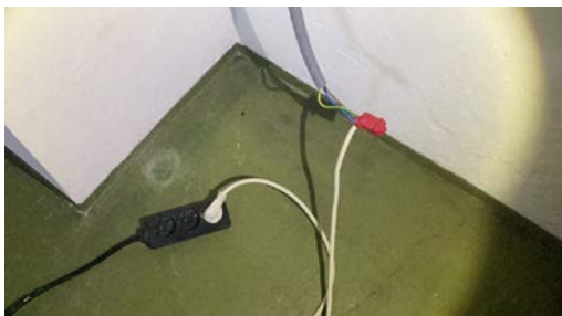
Eksempel på ulovlig kobling.
