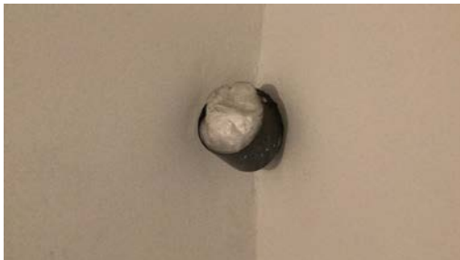
Åpent røykrør i pipe.
