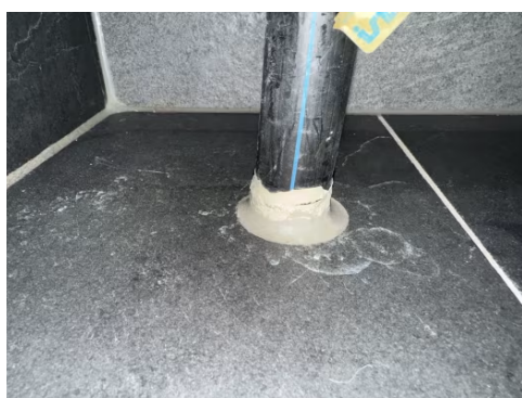
Synlig membran på rørføring i gulv.
