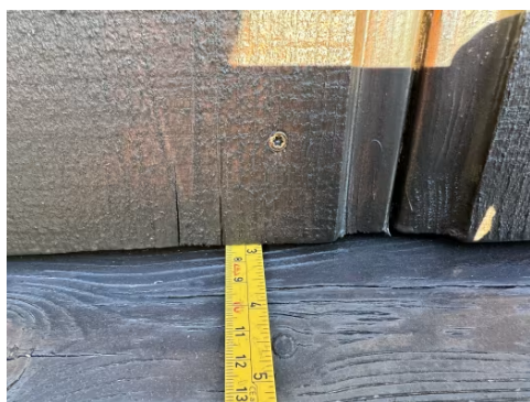
Høyst sannsynlig luftespalte bak kledning.
