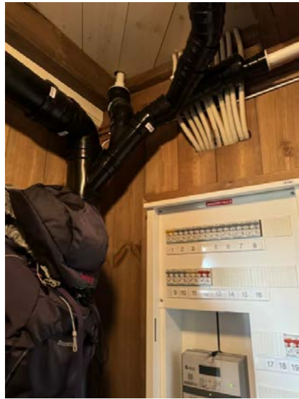
Avløpsrør i plast.
