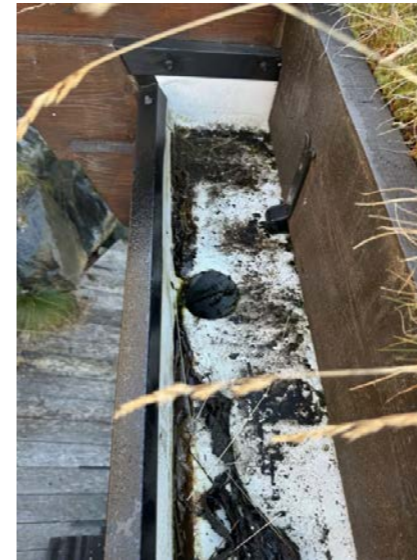
Vann blir samlet i renne av duk og videre ned i nedløpsrør.
