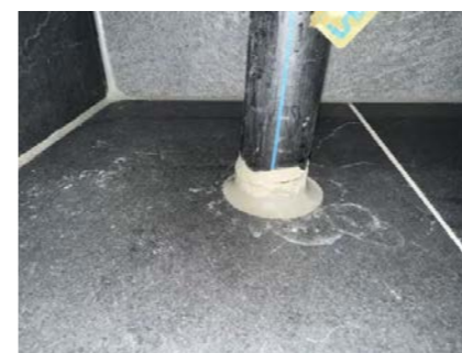
Synlig membran på rørføring i gulv.
