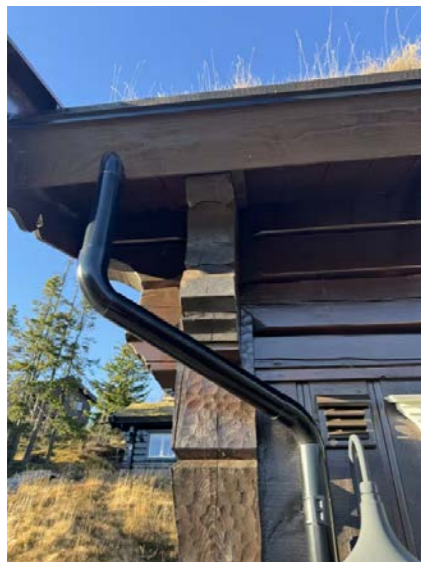
Nedløp i plastbelagt stål.
