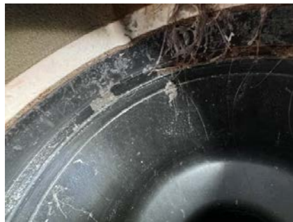
Vanskelig å bekrefte membran i sluket, men det er noe synlig tettesjikt under klemring.
