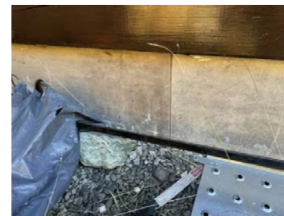
Isolerte ringmurselementer.
