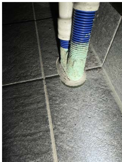
Synlig membran på rørføring.
