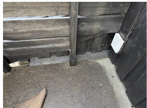
Veranda mot sør. Treverk mot betong.
