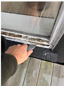
Vindu i stue ved terrasse mot sør.
