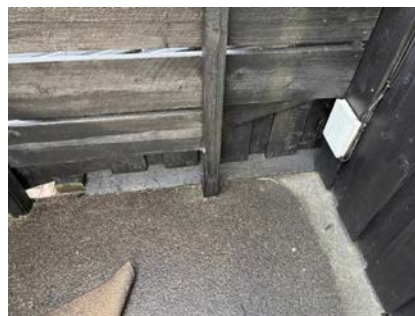
Veranda mot sør. Treverk mot betong.
