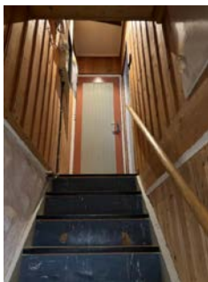
Trapp mellom kjeller og hovedetasje.
