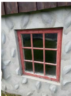
Eksempel på værslittasje utvendig
