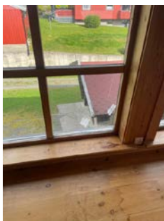
Eksempel på værslittasje utvendig
