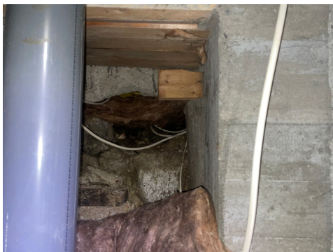
Deler av kryperom synlig fra kjeller. Synlig fukt i området
