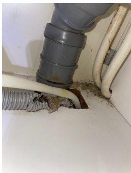
Skader på vann og avløpsrør tilknyttet oppvaskmaskin
