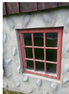
Eksempel på værslittasje utvendig
