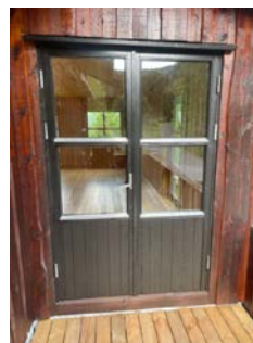
Eksempel på balkongdør med værslitasje og løse klinker
