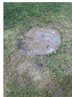
Betongkum på nedside av bolig.
