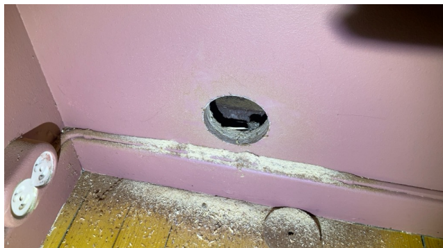
KJELLERETASJE (TILBYGD DEL) > BAD/WC/VASKEROM
