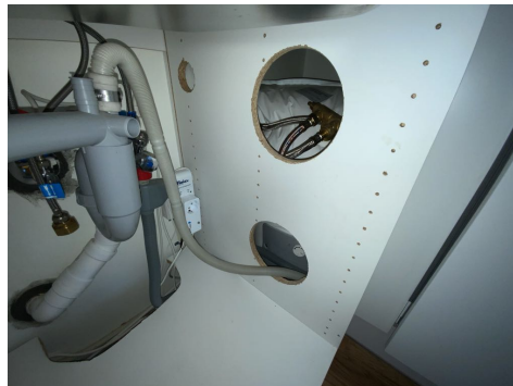
Besiktigelse av bereder.
