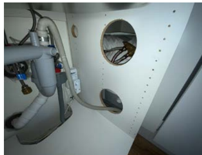
Besiktigelse av bereder.
