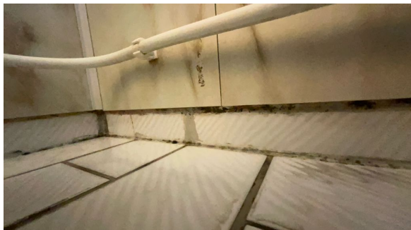
Buling på plate i våtsone.
