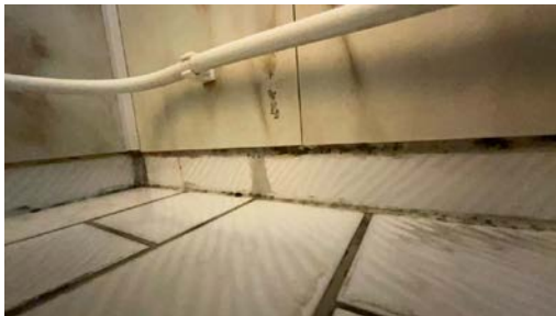
Buling på plate i våtsone.
