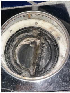
Plastsluk med klemring for membran
