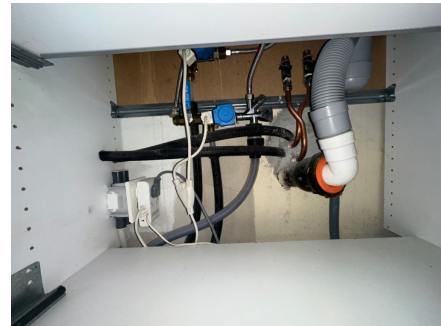
Røropplegg i kjøkkenbenk med Waterguard
