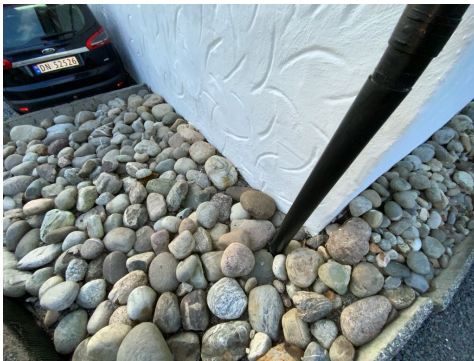
Kontroll av drenering/fuktsikring.
