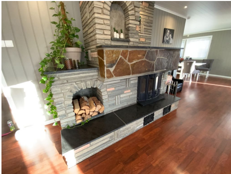
Besiktigelse av ildsted.
