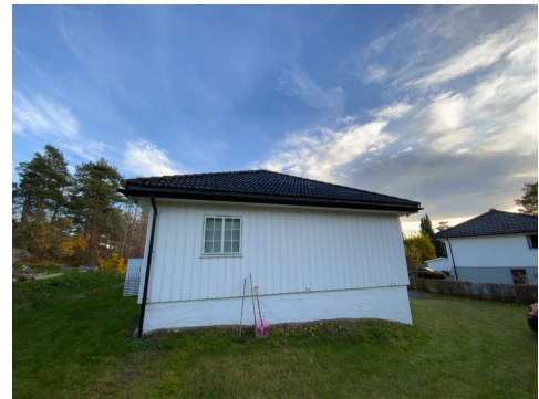
Besiktigelse av taktekke.
