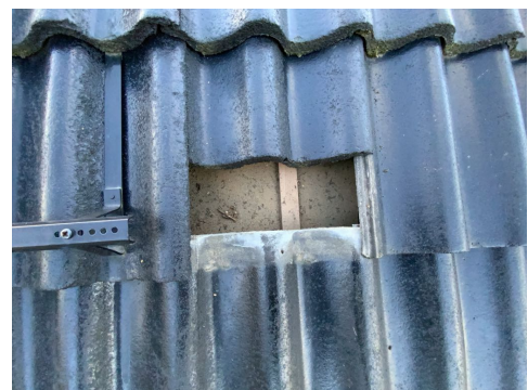
Kontroll av undertak.
