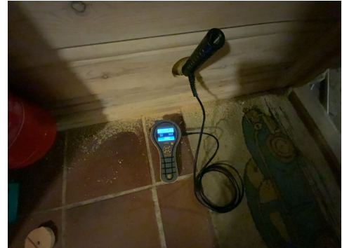
Utført hulltaking på rom under terreng.
