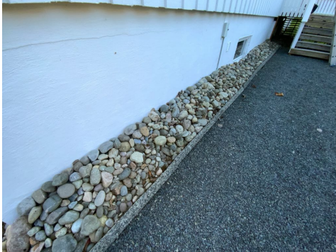
Kontroll av drenering/fuktsikring.
