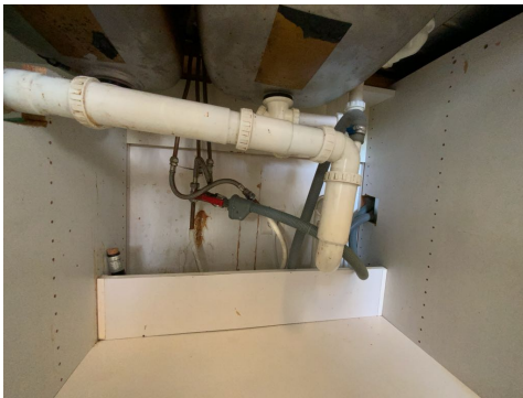
Besiktigelse av røropplegg.
