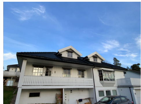
Besiktigelse av taktekke.
