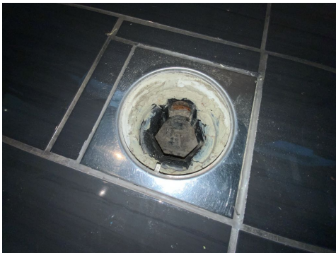
Kontroll av sluk.
