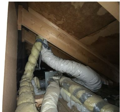
Kontroll rundt rørgjennomføringer.
