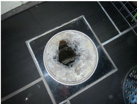
Kontroll av sluk.
