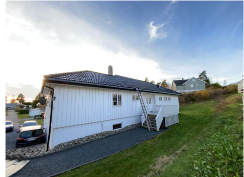
Besiktigelse av taktekke.
