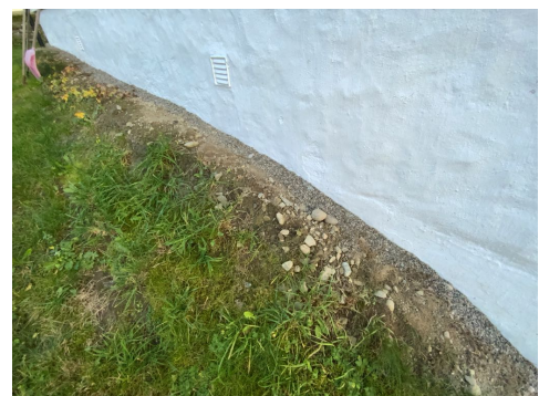
Kontroll av drenering/fuktsikring.
