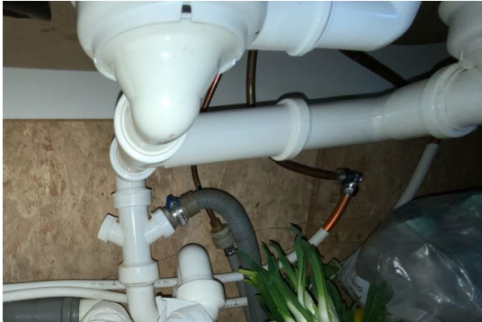
Besiktigelse av røropplegg.
