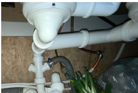
Besiktigelse av røropplegg.
