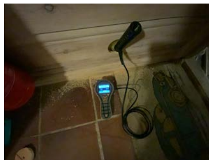
Utført hulltaking på rom under terreng.
