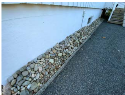
Kontroll av drenering/fuktsikring.
