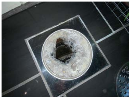
Kontroll av sluk.
