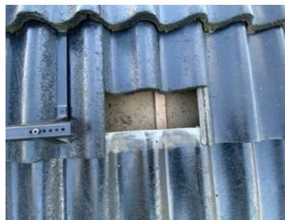
Kontroll av undertak.
