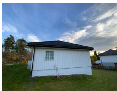
Besiktigelse av taktekke.
