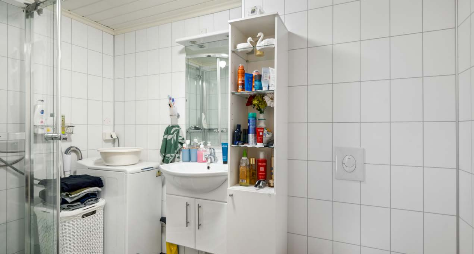
Flislagt baderom i hybelleilighet med dusjkabinett, veggghent wc og servant på baderomsinnredning. Det er opplegg for vaskemaskin og badet har gulvvarme.
