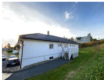
Besiktigelse av taktekke.
