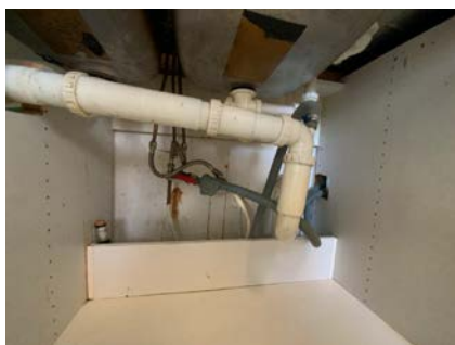
Besiktigelse av røropplegg.
