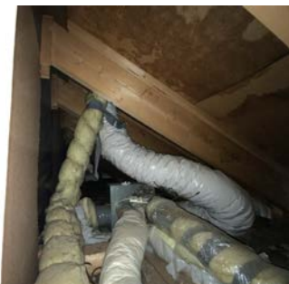
Kontroll rundt rørgjennomføringer.
