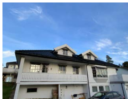
Besiktigelse av taktekke.
