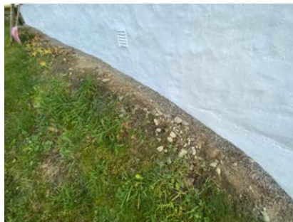
Kontroll av drenering/fuktsikring.
