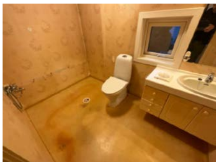
Foto av dusjbad
