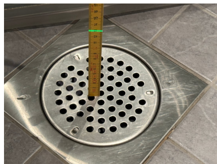
Fallforhold ca. 130 mm topp slukrist i dusjsone
