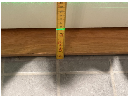
Fallforhold ca. 103 mm overkant gulv ved terskel
