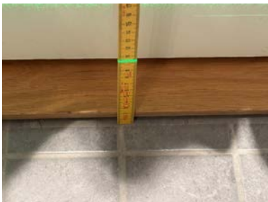
Fallforhold ca. 103 mm overkant gulv ved terskel
