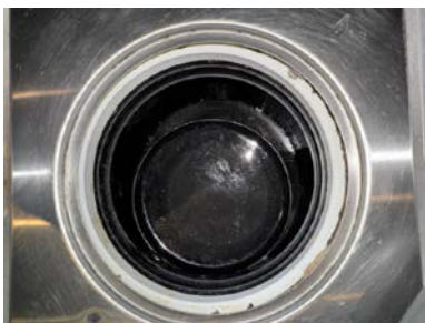
Plastsluk med klemring og synlig membran/mansjett
