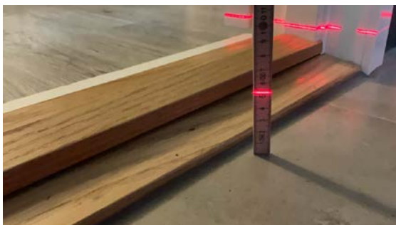
Høyde gulv ved dør.
