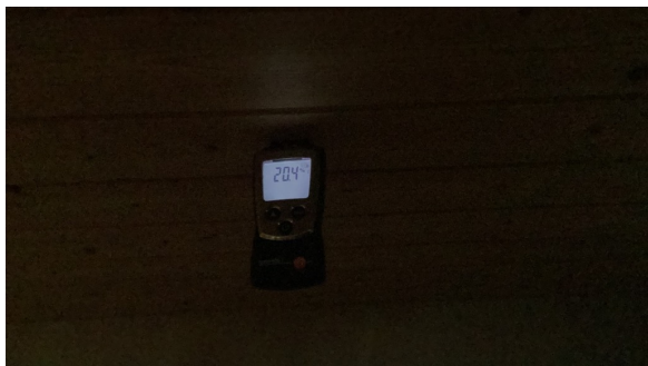
Fuktinnhold i treverk på rett over 20 vektprosent.
