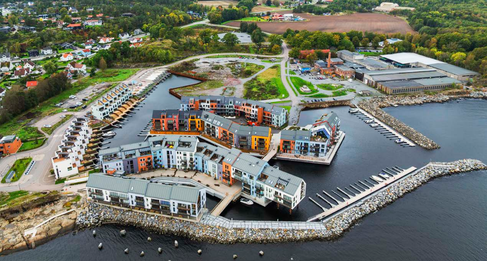
Sjøparken vokser frem og Øy 3 og Øy 4 er nå ferdigstilt.
