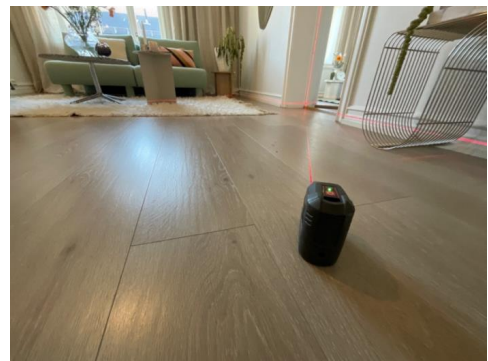
Nivellering stue, soverom, avvik ca. 10-20 mm
