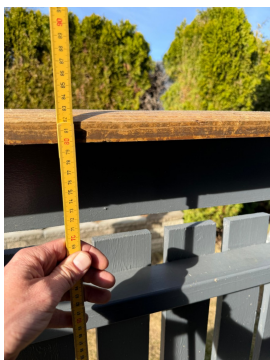
Bildet viser rekkverkets høyde ved inngangspartiet.
