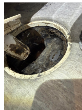
Bildet viser utskjæring i baderomsplater ved servant.
