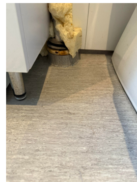
Bildet viser utskjæring i baderomsplater ved servant.
