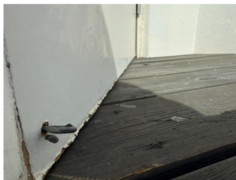
Bildet viser ytterdør til underetasjen.
