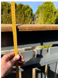
Bildet viser rekkverkets høyde ved inngangspartiet.
