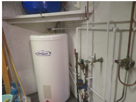
Vanninntak i ny del.
