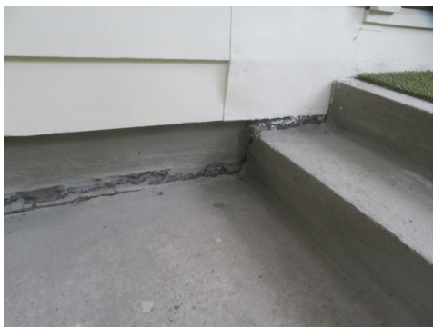
Sprekkdannelse ved murtrapp til gammel del.
