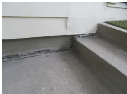
Sprekkdannelse ved murtrapp til gammel del.
