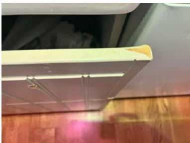
Slitasje merker på dør til oppvaskmaskin.
