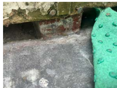
Tekking på 2 etasje av sinkplater.
