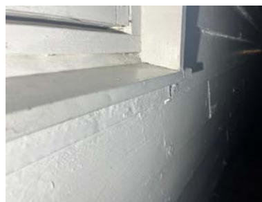
Bad 1 etasje, råteskader på glassramme.
