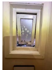
Bad 1 etasje, råteskader på glassramme.
