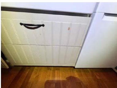
Slitasje merker på dør til benkeskap
