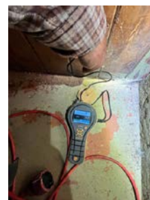
Målt i vegg mellom bad og gang
