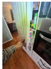
Slitasje merker på dør til kjøleskap
