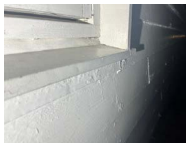
Bad 1 etasje, råteskader på glassramme.
