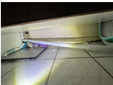
Åpning i vegg bak servantskap
