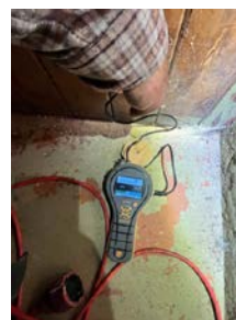
Målt i vegg mellom bad og gang
