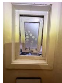
Bad 1 etasje, råteskader på glassramme.
