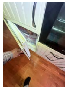
Slitasje merker på dør til fryseskap
