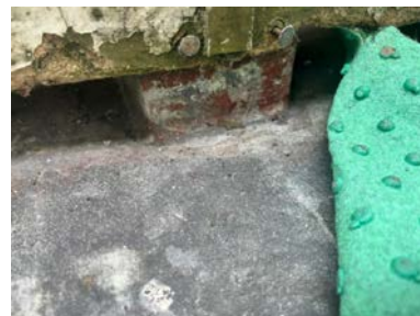
Tekking på 2 etasjen av sinkplater.
