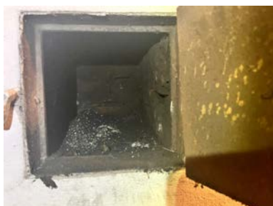
Plate under ovn på 1 etasje er for liten
