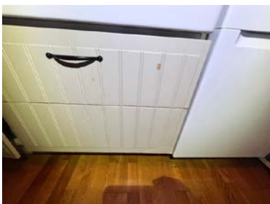
Slitasje merker på dør til benkeskap
