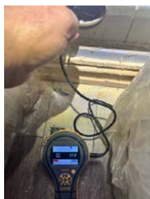
Målt i yttervegg mot grunnmur i naborom.
