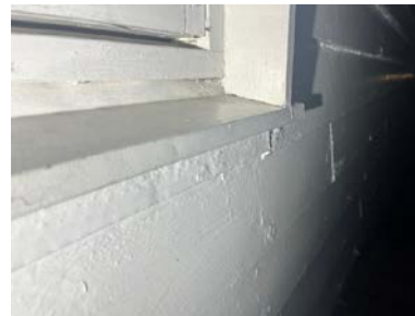
Bad 1 etasje, råteskader på glassramme.
