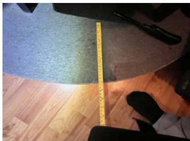
Plate under ovn på 1 etasje er for liten
