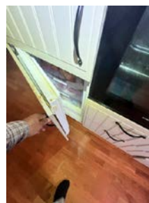
Slitasje merker på dør til fryseskap
