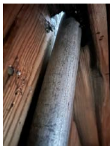
Åpning rundt rørgjennomføring i taket.
