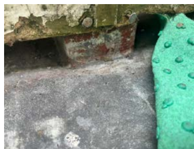
Tekking på 2 etasje av sinkplater.
