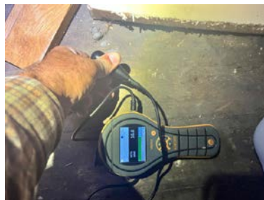
Målt på gulv med tilfarer konstruksjon
