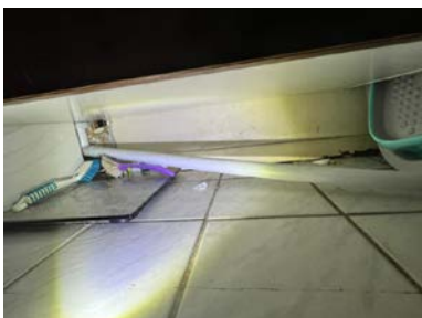
Åpning i vegg bak servantskap
