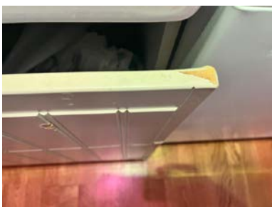
Slitasje merker på dør til oppvaskmaskin.
