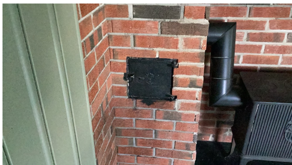
Sotluke på kjøkken
