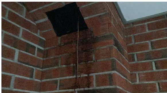
Sotluke på kjøkken.
