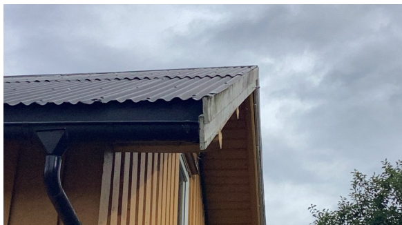
Takplater er lagt ut over vindskier.
