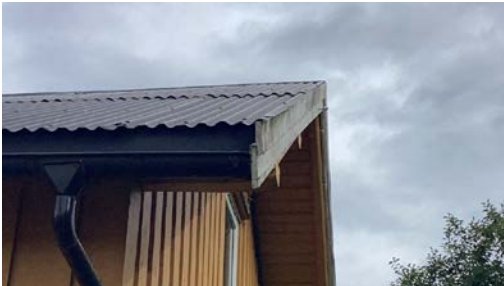
Takplater er lagt ut over vinds kier.
