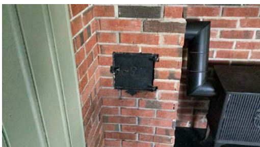
Sotluke på kjøkken
