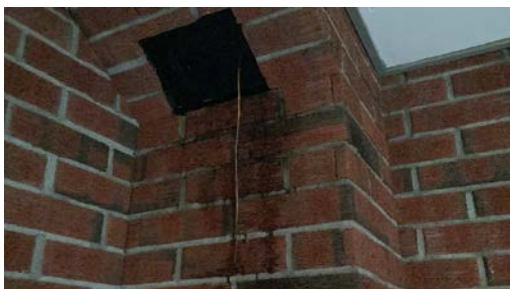
Sotluke på kjøkken.
