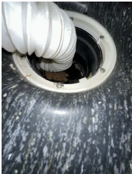
Det registreres hull tettesjikt/ gulvbelegg ved sluk. (TG3)
