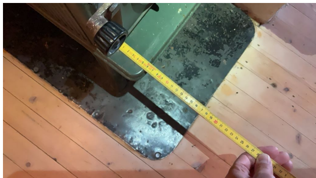
Plate på gulv under ovn er for kort ihenhold til krav
