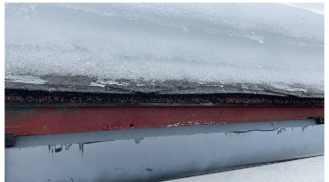
Tekking oppå eksisterende teking
