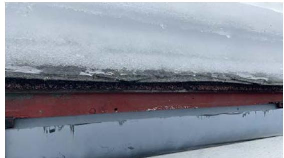
Tekking oppå eksisterende teking
