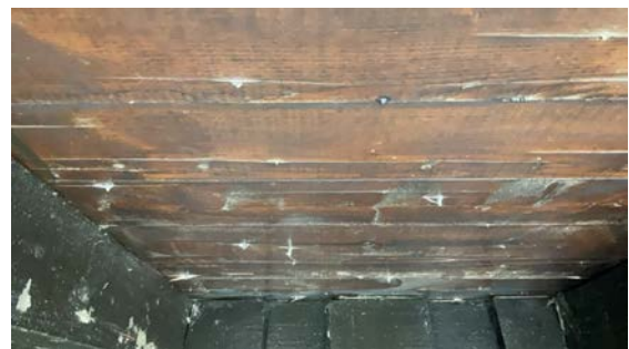
Synlig innfesting via undertak
