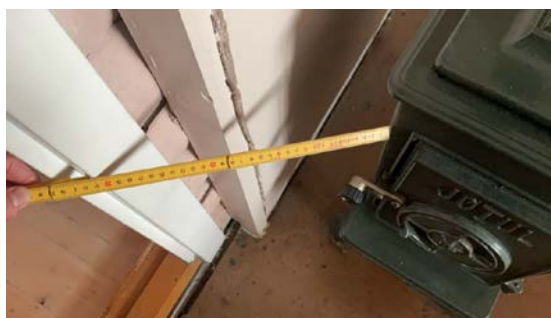
For kort avstand til brennbart materiale
